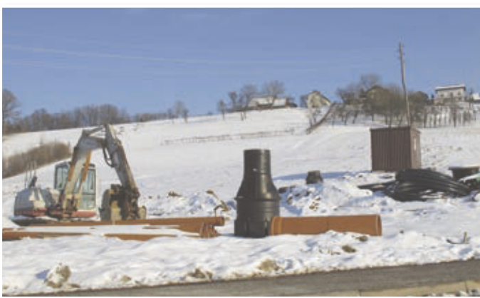
Tako so pozimi leta 2015 začeli komunalno opremljati novo naselje v Benediktu, ki ga gradi podjetje Juven.
